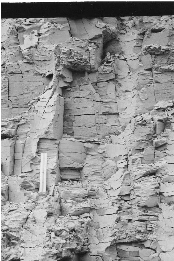
Fig. 2. Carrière Krasny Bor. Profondeur : 12,5 m. Règle : 20 cm. Vue générale de la fracturation. Fraîcheur des joints. Importance relative des discontinuités verticales (photo : M. Arnould).
